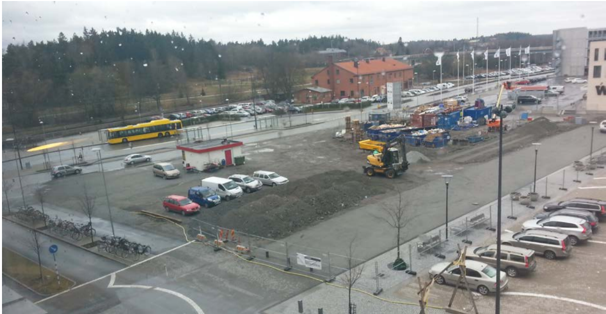
Gredelby 7:85 (kv. Virkesladan) från sydost
