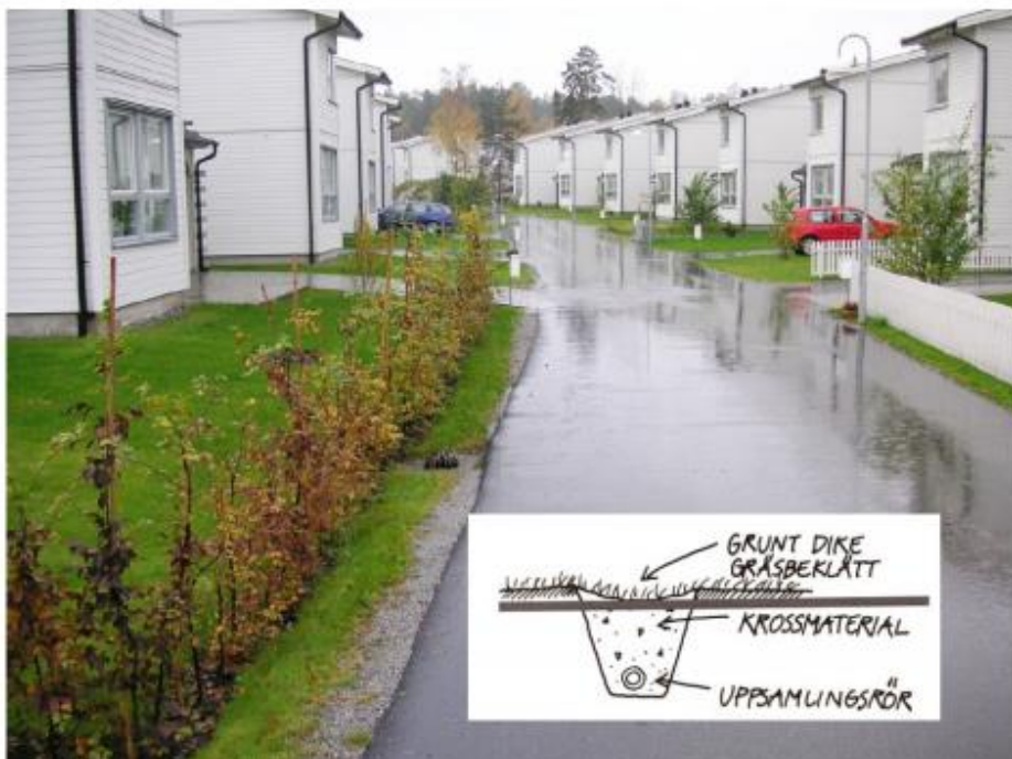
Figur 7: Ett långsmalt infiltrationsstråk gömmer sig under gräset mellan gatans stödrens och den nyplanterade häcken.
