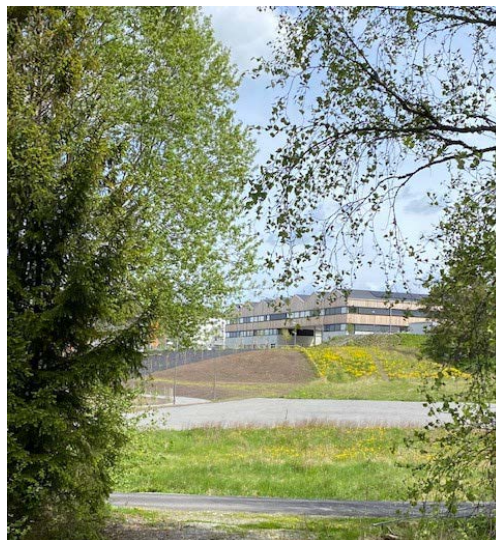
Figur 8 Adolfsbergsskolan sett från Norra Alängsvägen
