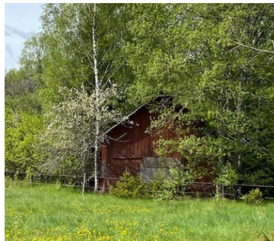
Figur 7. komplementbyggnad på Vrå 1:35
