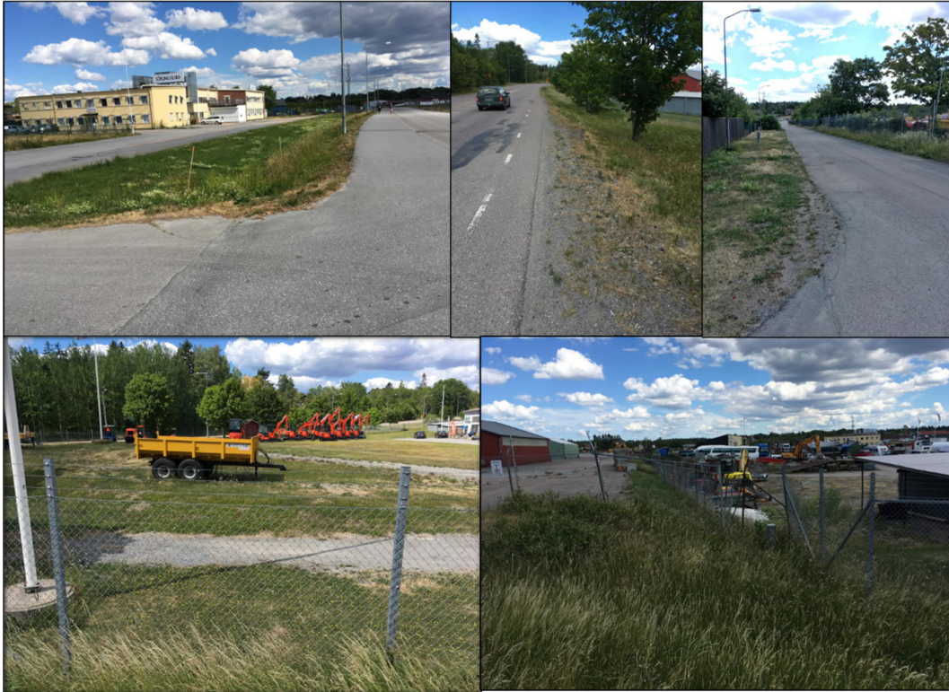
Figur 4. Kollage från planområdet. Övre raden från vänster: Knivstavägen, Gredelbyleden Undre raden: Förrådsvägen, sydvästra hörnet av industriområdet, höjdskillnader på industriområdet fotat västerifrån.
