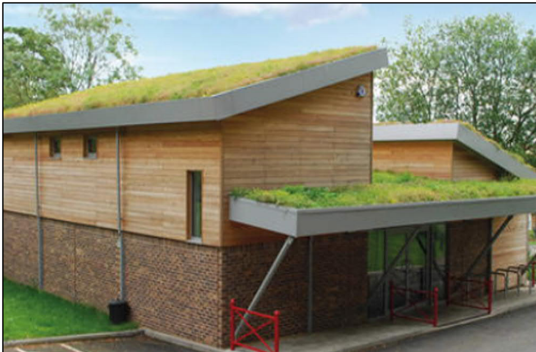
Figur 12. Sedumtak kan anläggas både på platta och lutande tak (Svenska Naturtak AB, 2018).
