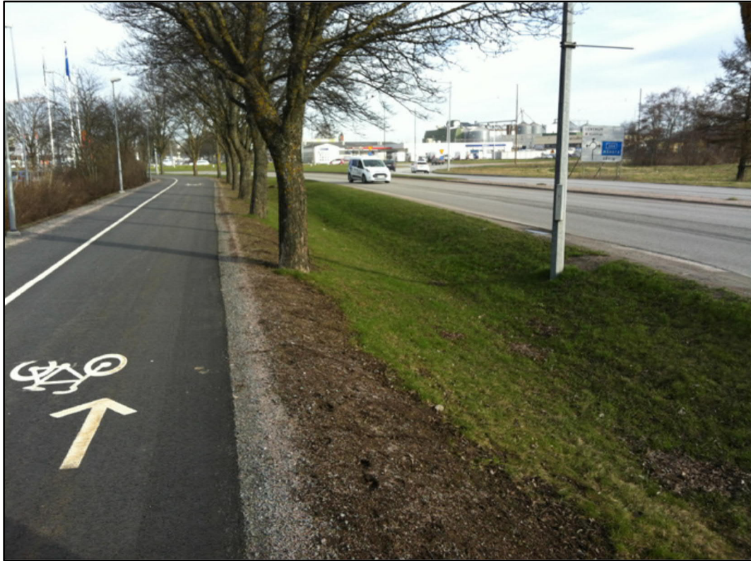
Figur 19. Svackdike mellan gång och cykelväg (Stockholm Vatten och avfall, 2018)
