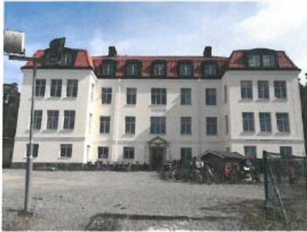
Den högra huvudbyggnadens fasad mot parken
