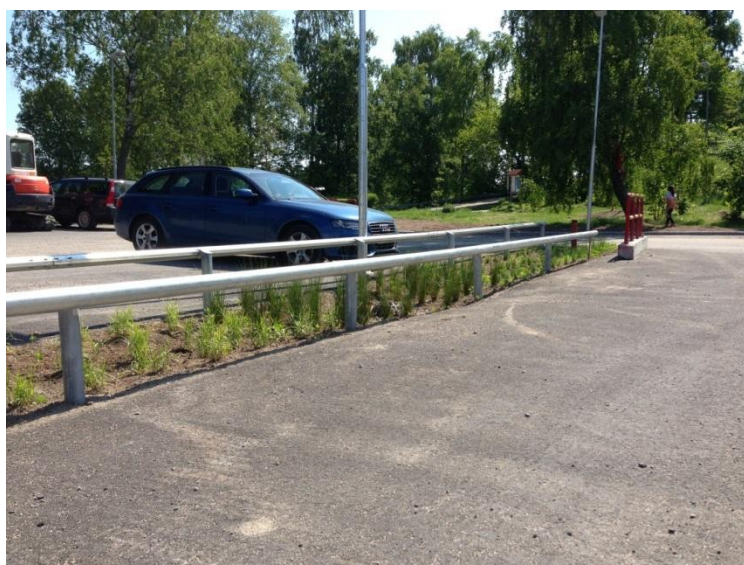
Figur 11. Växtdike mellan parkeringar dit dagvatten kan avrinna.
