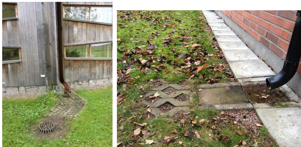
Figur 8. Utkastare till dagvattenbrunn respektive infiltration.
