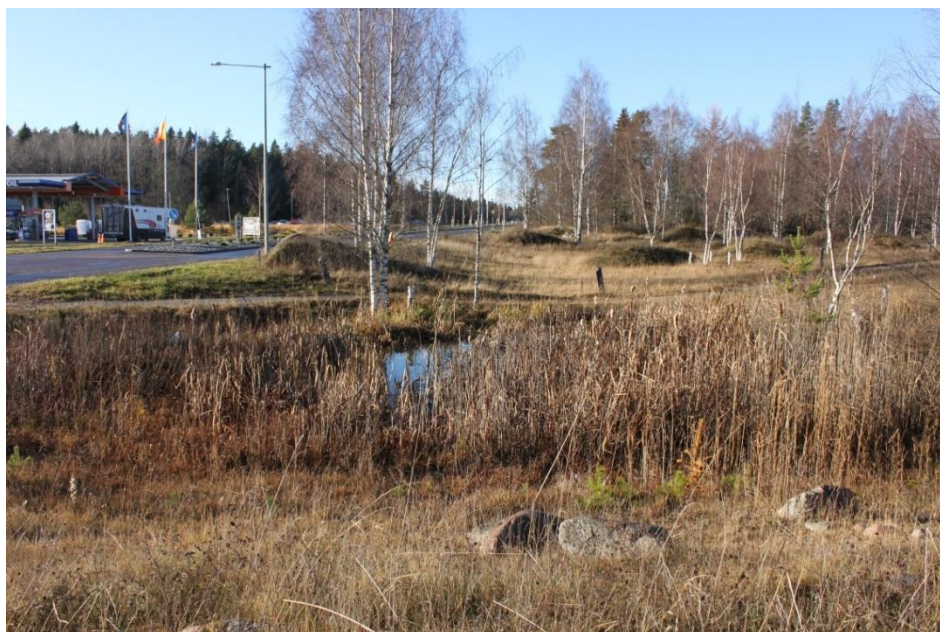
Figur 10. Befintlig damm som kan fördröja och rena en del av östra avrinningsområdet.
