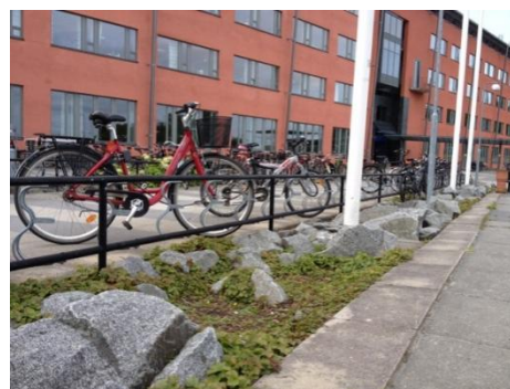
Figur 9. Avrinning i krossdike, svackdike med och utan dränerande botten. Längst ner t.h. exempel på krossdike i en hårdgjord yta.
