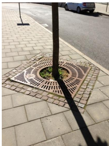
Figur 12. Träd som planterats i skelettjord dit dagvatten kan ledas och infiltrera. T.h. Principskiss på utformning av trädgropar i stadsmiljö, idé från Malmö stads tekniska handbok, (Teknisk handbok, Malmö stad, 2015)
