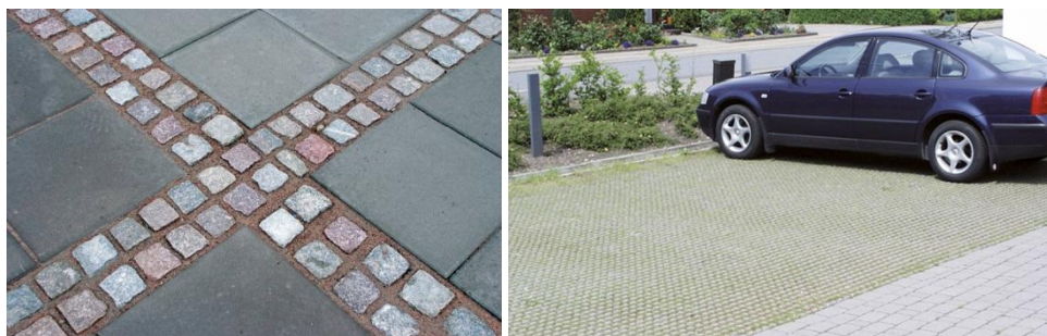
Figur 10. Gles plattsättning med sandfog och gräsarmering är två ytbeläggningar som minskar avrinningen.
