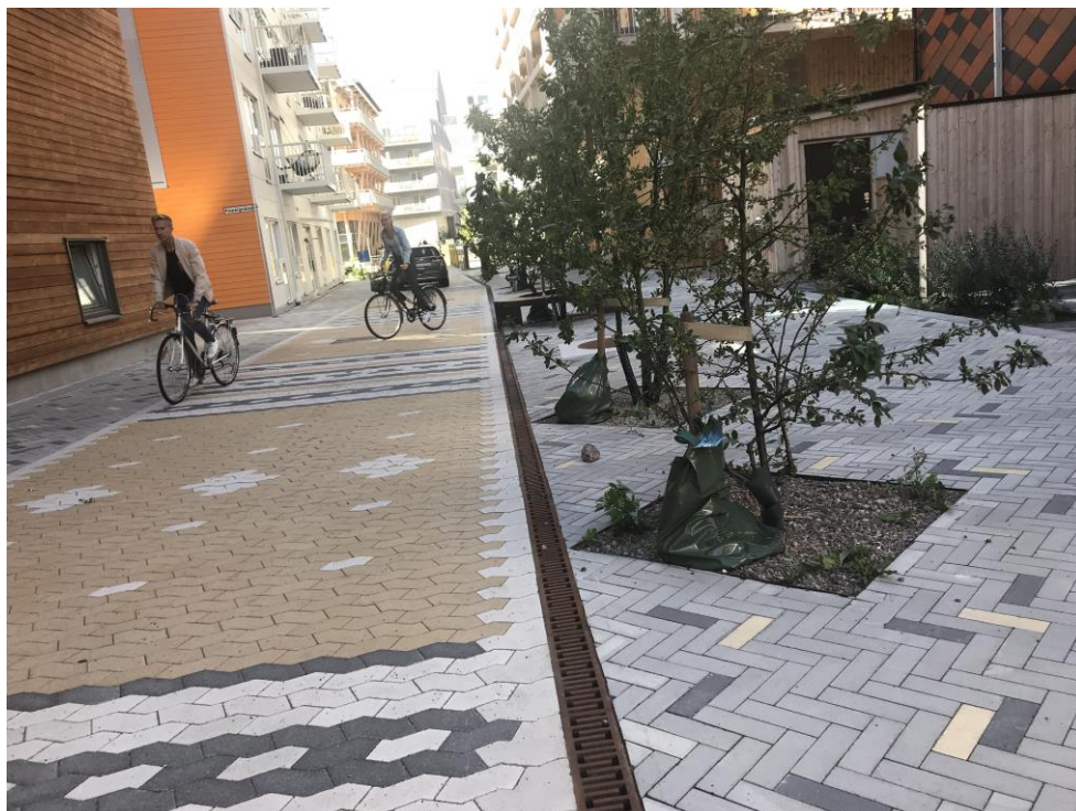
Figur 2.14. Exempel på utformning av en barn- och cykelvänlig gata i Vallastaden i Linköping. Utformningen kännetecknas bl.a. av att den är visuellt intressant att färdas långsamt på. Utformningen gör det normalt att cykla två i bredd när man så önskar. Notera att i nordöstra delen av planområdet är bebyggelsen mindre tät än vad bilden illustrerar. Foto: Trafikutredningsbyrån
