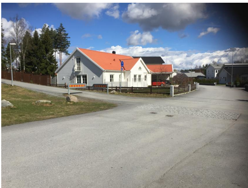
Figur 4.6. Där cykelbanan korsar Åsgatan bör trafiksituationen anpassas så att cyklisterna har företräde. Idag finns otydliga markeringar i vägbanan och grindar som stoppar cyklister på denna lugna villagata.
