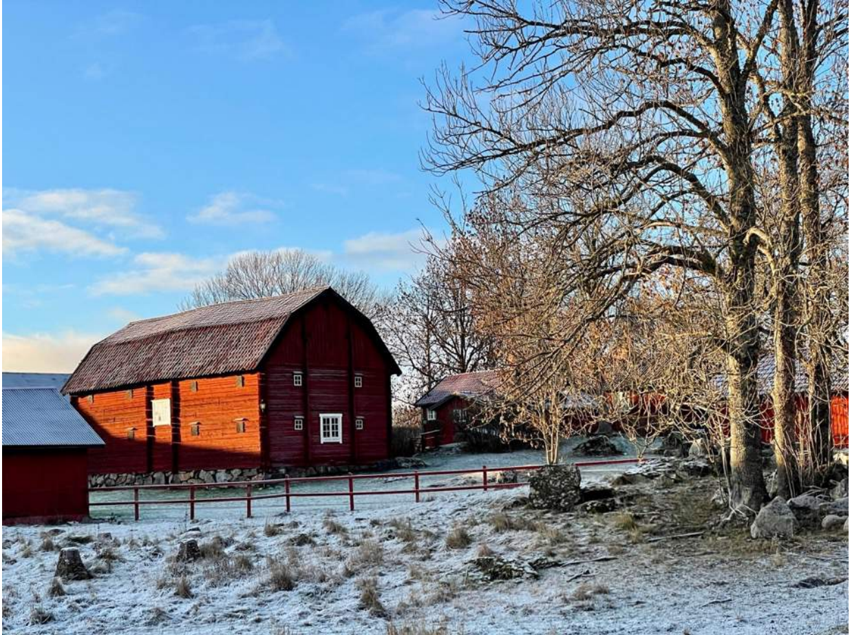
Figur 2. Vy från sydost mot ett tidigare magasin och andra byggnader som historiskt hört till gårdsbruket vid Noors säteri. Byggnaderna ligger inom riksintresset men utanför utredningsområdet.
