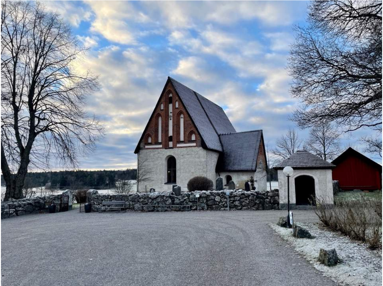
Figur 4. Knivsta gamla kyrka. Den välbevarade kyrkobyggnaden representerar de tegelornamenterade gråstenskyrkor med salkyrkoplan som uppfördes i Uppland omkring år 1300. Kyrkan ligger inom riksintresseområdet.
